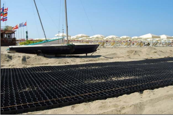
Şek.1 Runfloor'un kumsal üzerinde kurulumu
