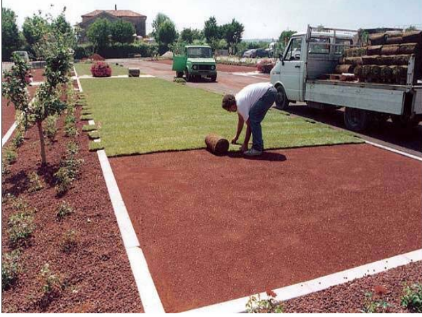
Şek.1 Çim rulolarının serilmesi
