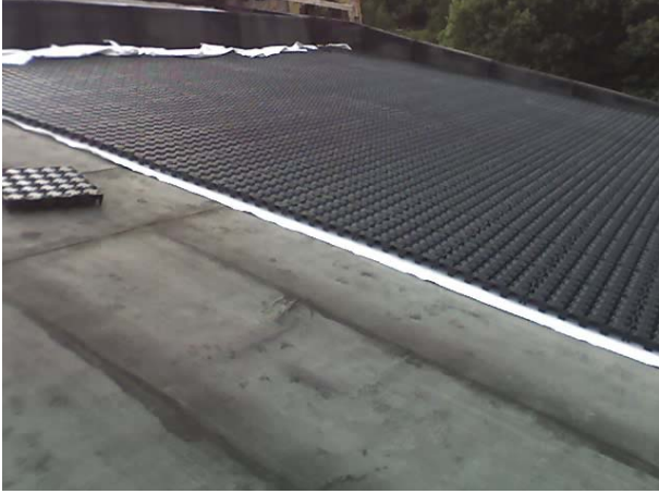
Şek.1 Drainroof kurulumu
