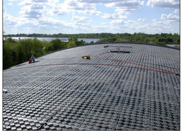
Şek.2 Bitmiş Drainroof kurulumu
