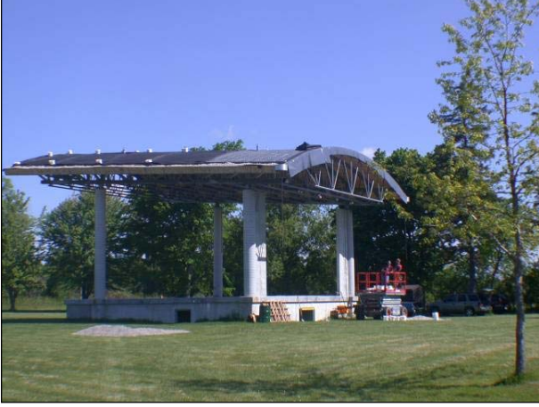
Şek.1 Uygulama sahası
