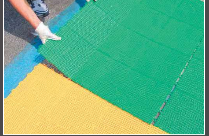
Önceden birleştirilmiş parçaların takılması
