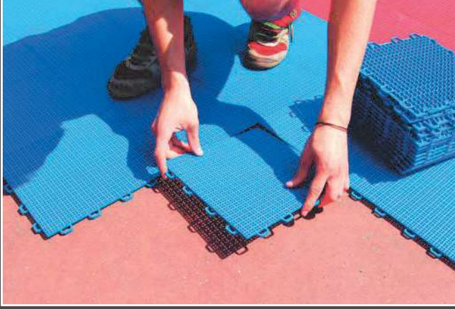
Tek bir GRIPPER® parçasının takılması
