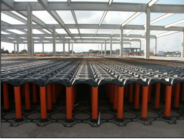
Şek.1 Montajı tamamlanmış Yeni Elevetor
