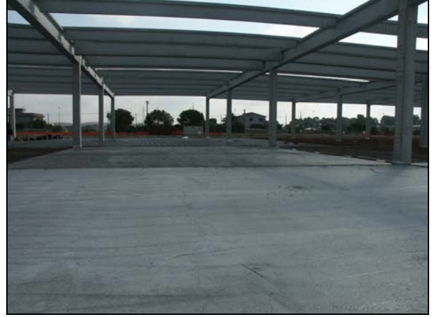
Şek.2 Bitmiş beton dökümü
