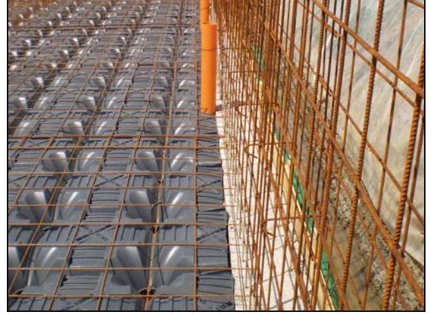
Şek.2 Çevre duvarına yakın kesilmiş kalıpların detayı
