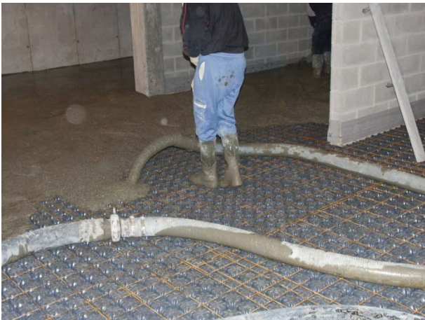
Şek.3 Beton dökme aşaması
