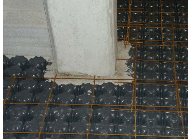
Şek.2 Kolonun yanındaki Modulo kesitinin detayı
