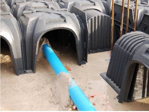
Şek.1 Modulo'nun altındaki tesisat detayı
