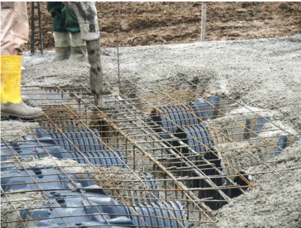
Şek.3 Zemin kirişine beton dökümü
