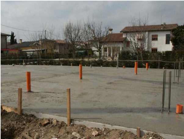
Şek.3 Döküm işlemi sonrasındaki zemin plağı
