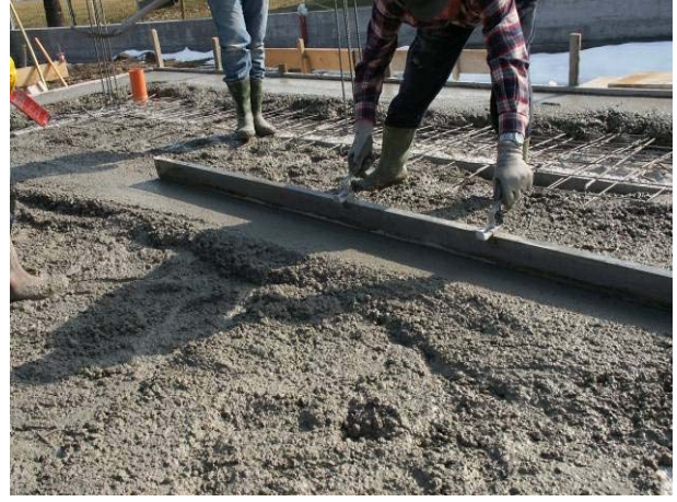
Şek.2 Dökülen betonun düzeltilmesi
