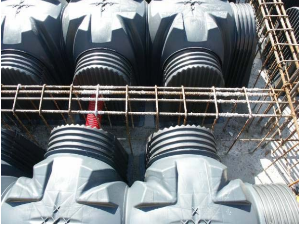
Şek.1 Zemin plağı bölümleri arasındaki havalandırma bağlantısının detayı
