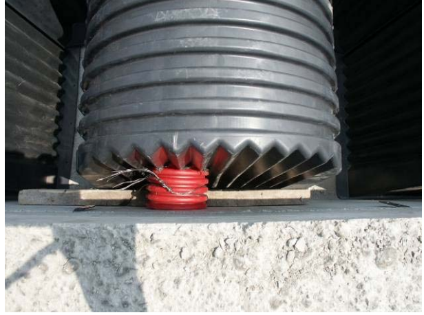
Şek.2 Çevre duvarı ile havalandırma bağlantısı detayı
