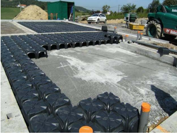
Şek.1 Modulo'nun montajı
