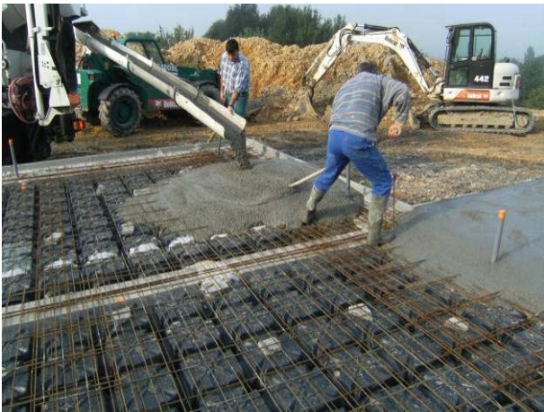
Şek.3 Beton dökümü
