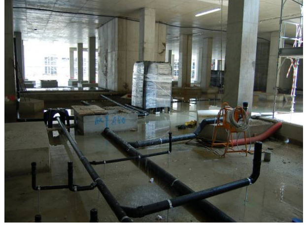
Şek.2 Tesisat montajı
