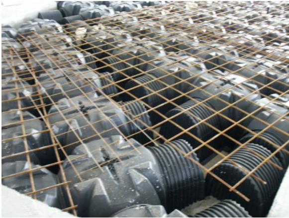
Şek.3 Geoblock yardımıyla oluşturulan köşenin detayı
