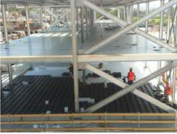
Şek.1 Kontrol menholü ve Geoblock detayı
