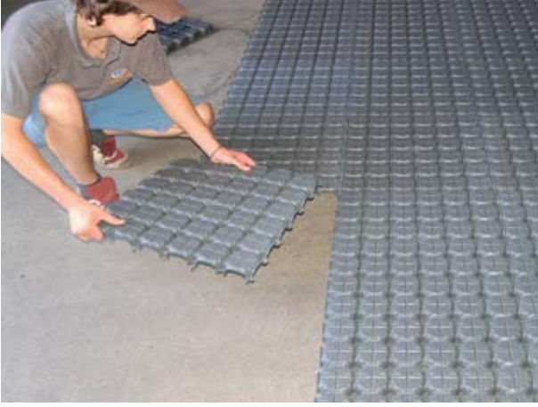
Şek.1 Minimodulo'nun montajı
