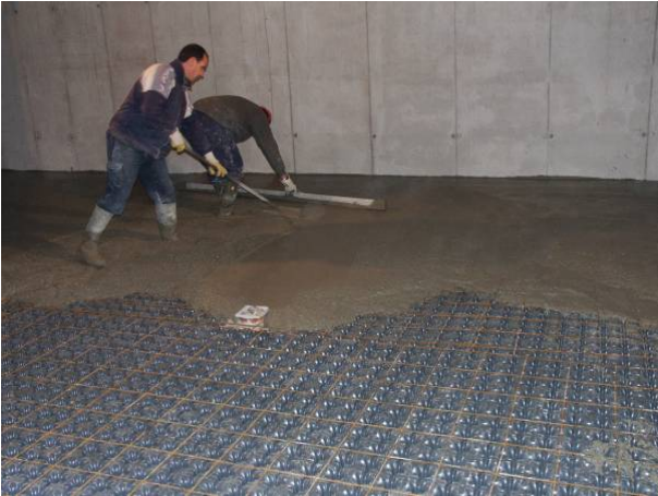
Şek.3 Beton dökme aşaması
