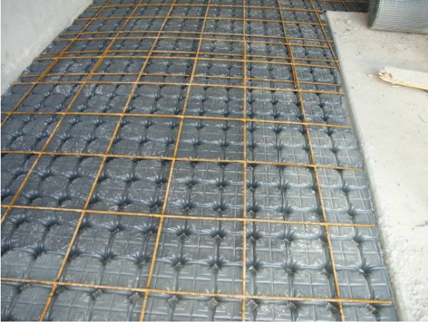
Şek.3 Monte edilmiş ve beton dökümü için hazır sistem
