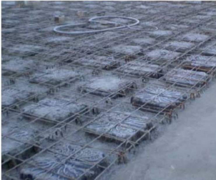
Şekil 1.8 : Birinci aşama beton dökümü.
