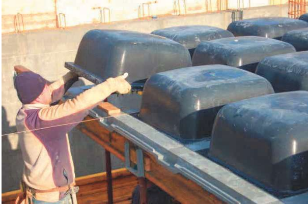
Şek.2 Hafif kalıplar aşağıdan montaja izin verir.
