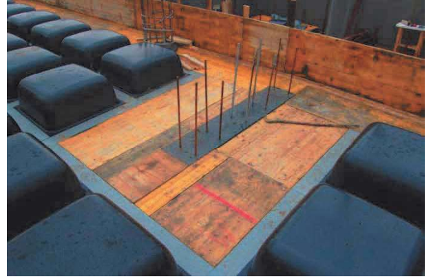
Şek.3 Ahşap ile perde etrafında kompanzasyon detayı
