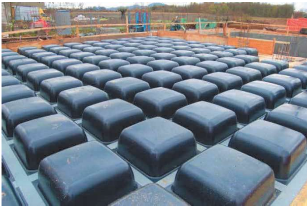
Şek.4 Oluşturulan kalıp yüzeyinin üstten görünümü
