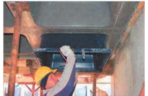
Şek.5 Kalıp kolayca sökülür.
