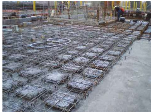
Şek.3 Beton dökümü
