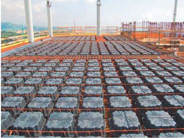
Şek.1 Yeni Nautilus'un montajı
