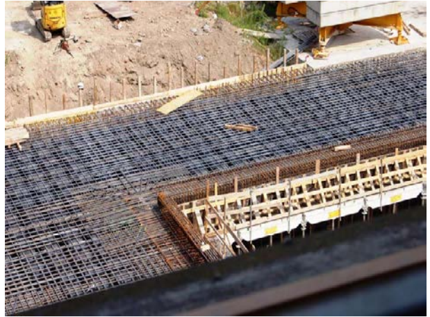
Şek.4 Şantiye üstten görünüşü
