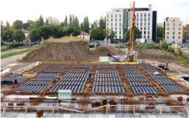
Şek.3 Döküme hazır kalıp alanı
