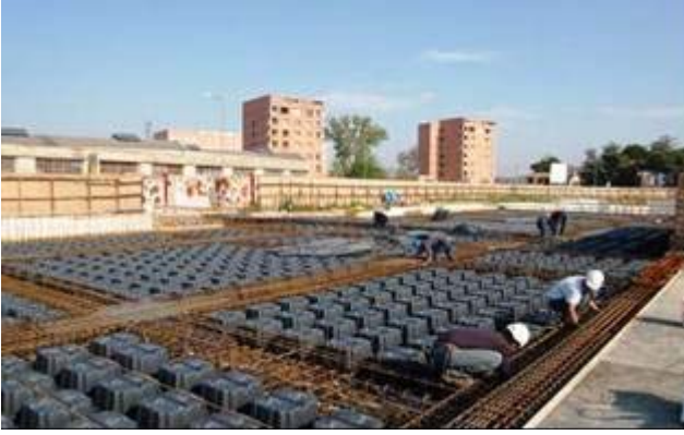
Şek.1 Uygulama sahası
