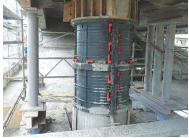
Şek.2 Geotub kalıplarının montajı
