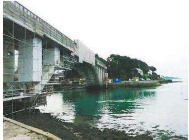
Şek.4 Köprünün genel görünüşü
