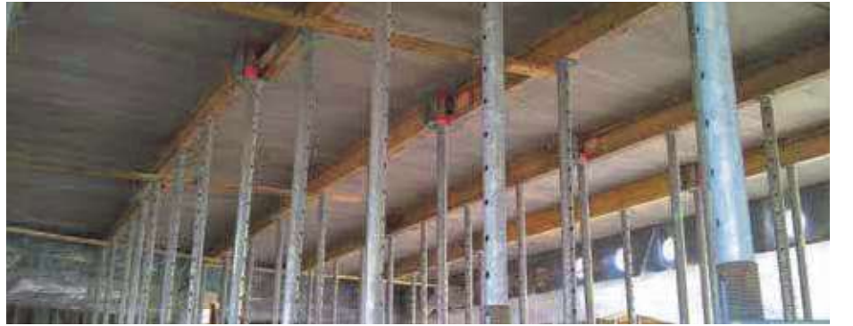
⑧ DÖŞEME KALIBININ SÖKÜMÜ
