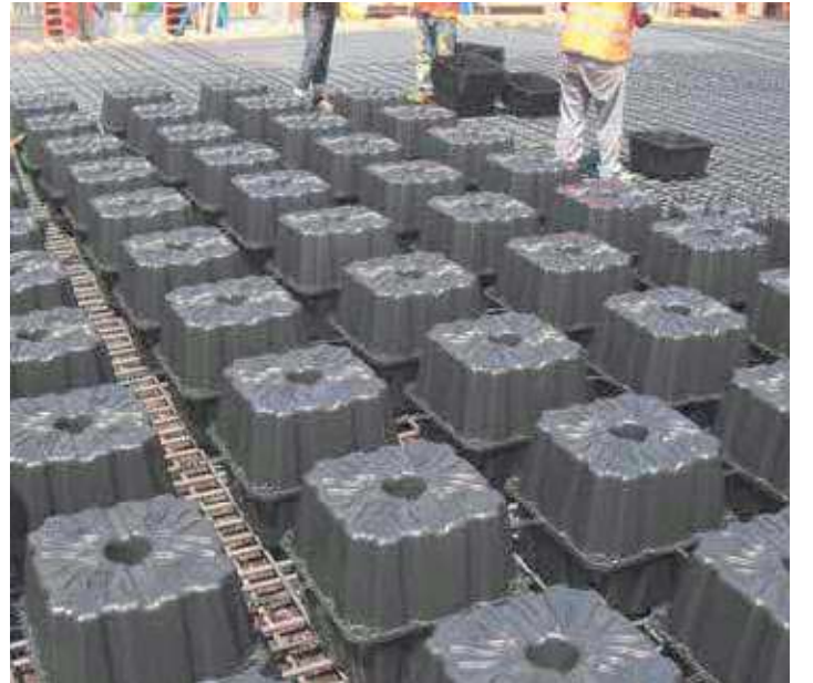
16 x 24 m açıklık, 100 cm döşeme kesiti (26 cm alt plak + H48 + 26 cm üst plak)
