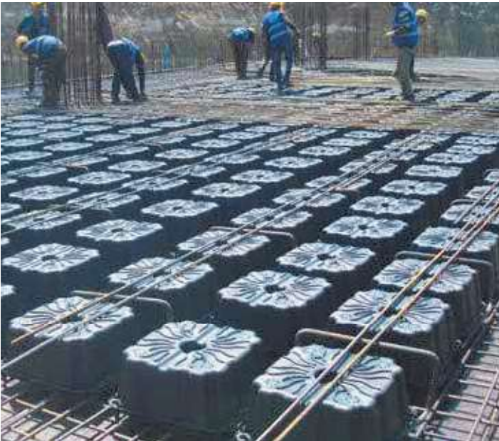
8 x 10 m açıklık, 40 cm döşeme kesiti (10 cm alt plak + H20 + 10 cm üst plak)
