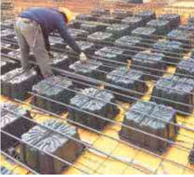
④ ÜST PLAK DONATISININ YERLEŞTİRİLMESİ
