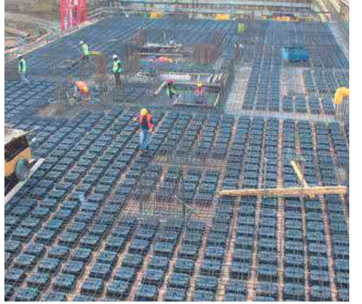
7,5 x 7,5 m açıklık, 30 cm döşeme kesiti (7 cm alt plak + H16 + 7 cm üst plak)
