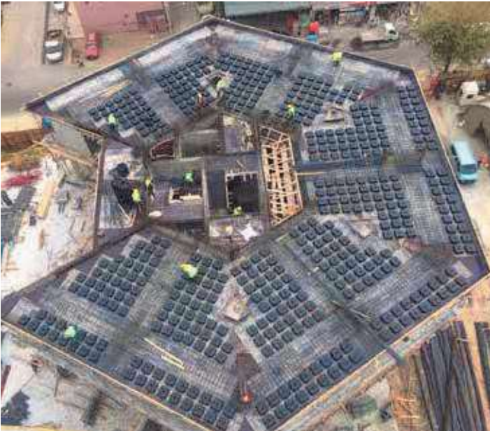
7 x 7,5 m açıklık, 30 cm döşeme kesiti (7 cm alt plak + H13 + 10 cm üst plak)
