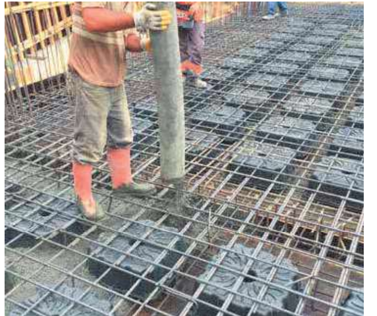
7 x 8 m açıklık, 30 cm döşeme kesiti (7 cm alt plak + H16 + 7 cm üst plak)
