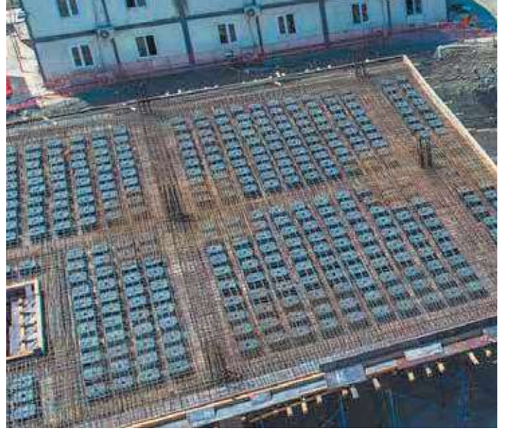
7,5 x 7,5 m açıklık, 35 cm döşeme kesiti (7 cm alt plak + H20 + 8 cm üst plak)
