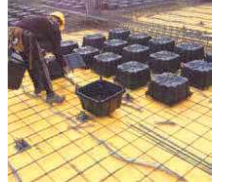
③ YENİ NAUTILUS EVO'NUN YERLEŞTİRİLMESİ
