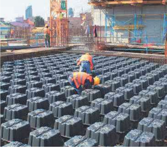
16 x 16 m açıklık, 70 cm döşeme kesiti (10 cm alt plak + H48 + 12 cm üst plak)
