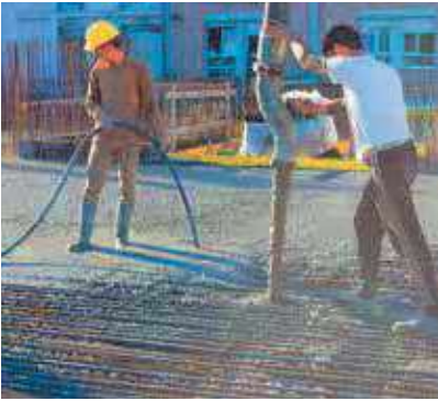
⑦ BETON DÖKÜMÜNÜN İKİNCİ AŞAMASI
