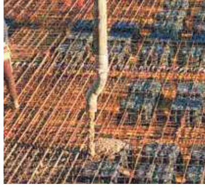
⑤ BETON DÖKÜMÜNÜN BİRİNCİ AŞAMASI
