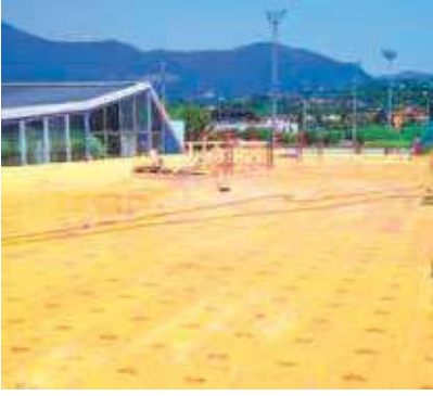
① DÖŞEME KALIBININ HAZIRLANMASI
