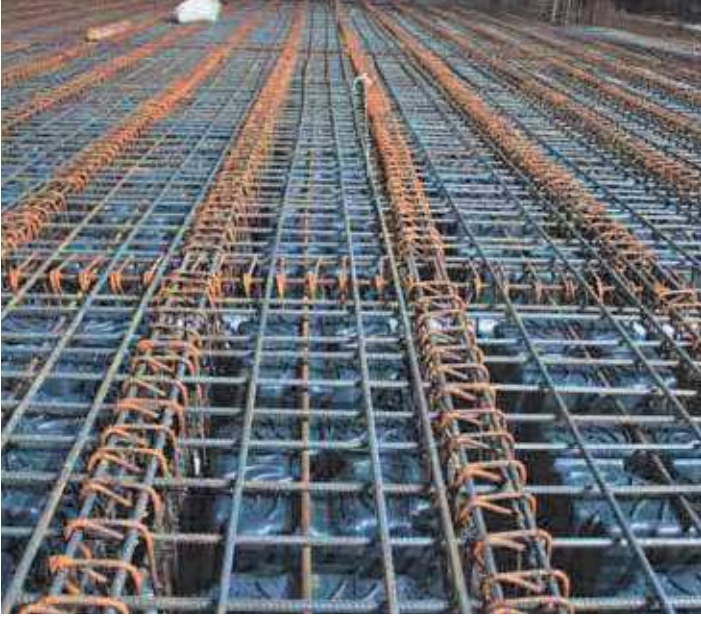
24 x 42 m açıklık, 86 cm ard germeli döşeme kesiti (15 cm alt plak + H56 + 15 cm üst plak)
