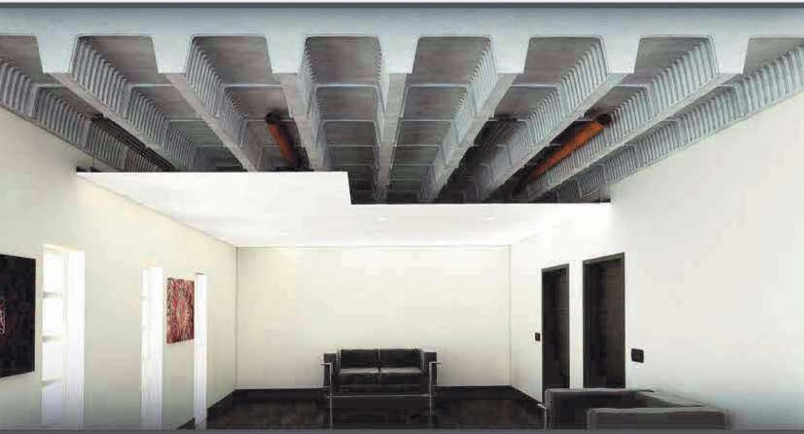
Tekrar kullanılabılır tek yönlü nervürlü döşeme kalıbı sistemi
