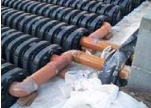
Şek.4 Geotekstil ve giriş borularının detayı
