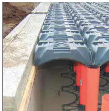
Cevre duvarlarına ankre edilmiş ahşap konsollar ile desteklenen kalıbin kesiti
