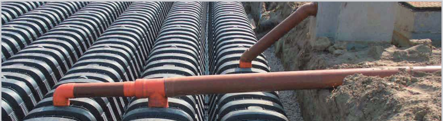
şekil 9) DRENING® sisteminin üstündeki tüplerin montaj örnekleri.
